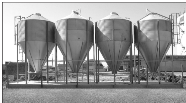
Бункера для перегрузки комбикорма напрямую с комбикормового завода на площадку ООО «БВК-ГЛОБАЛ» по откорму свиней.
