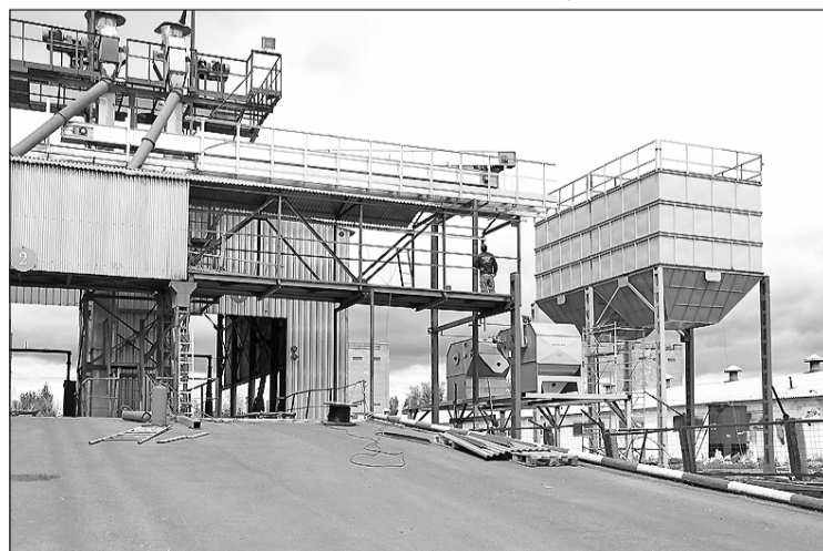
▲ Монтаж новых зерноочистительных машин ALFA производительностью 150 т/ч.
